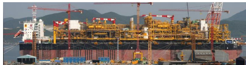
浮式生产系统 (FPSO)
